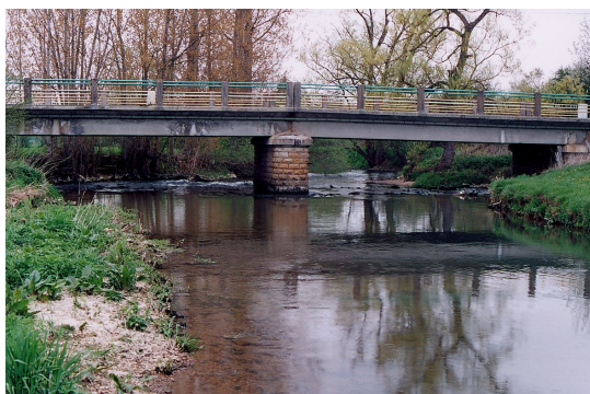
Pont de la RD44 à THIANCOURT
