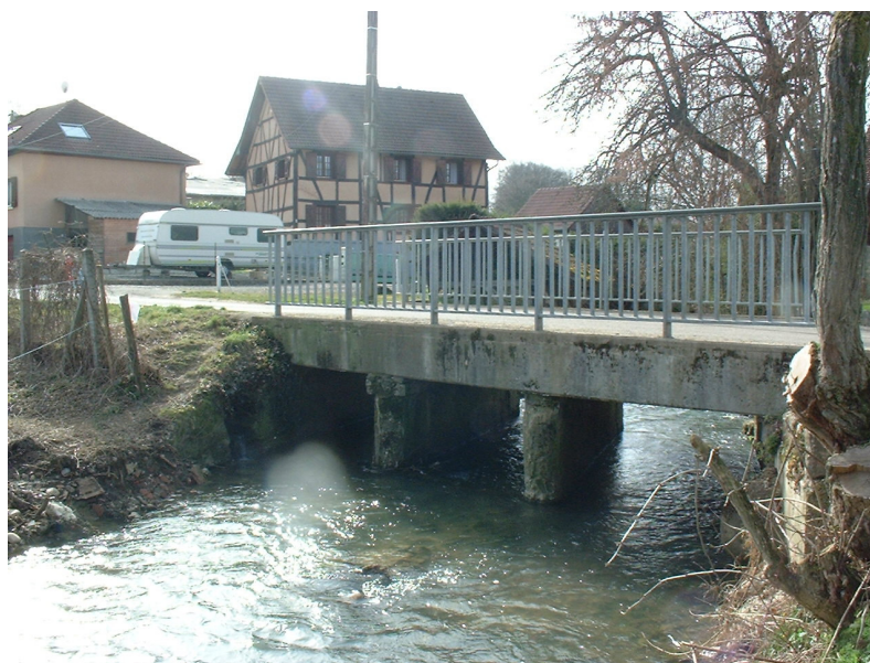
Ouvrage aval dans le bourg
