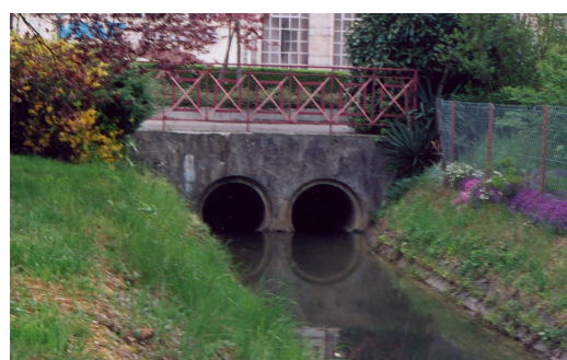
Franchissement du canal par la RD23
