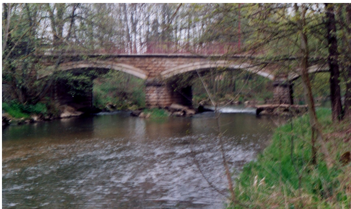
Pont de la RD23 sur le bras principal
