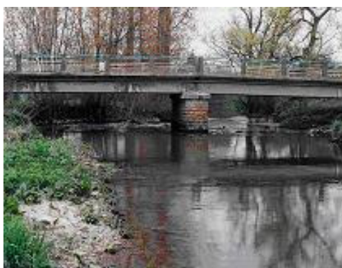
Pont de la RD44 à JONCHEREY
