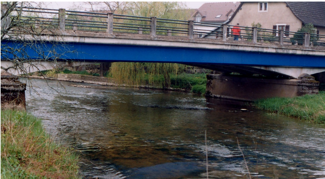
Pont de Grandvillars
