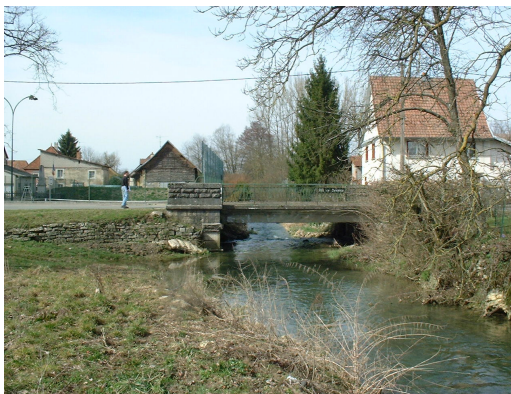
Franchissement amont de la Coeuvatte
