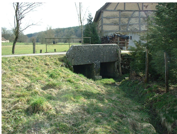
Pont sur la Coeuvatte
