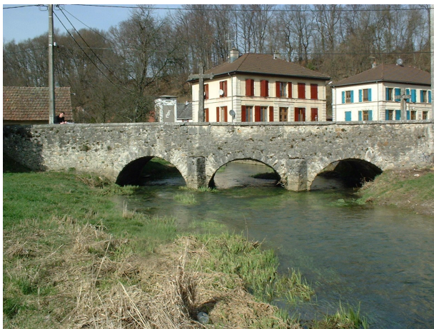
Pont sur la voie communale
