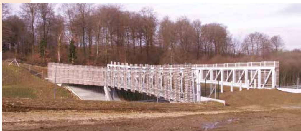
Passage à faune
