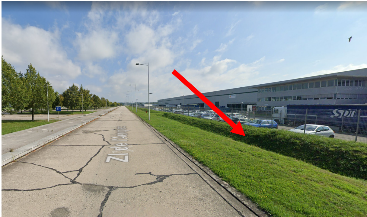
Photographie depuis l'avenue de la Grande Piste (noue végétalisée)
