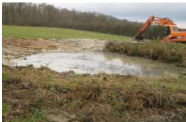
Travaux sur une mare.
