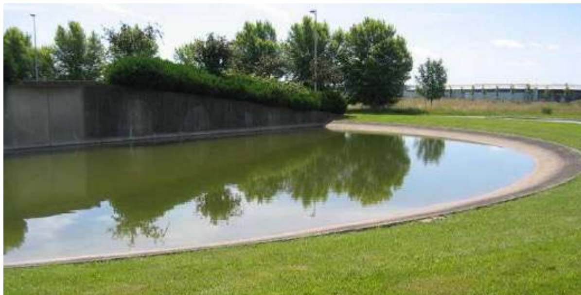
Pièce d'eau artificielle dans le rond-point d'accès au nord-ouest de l'Aéroparc (CLIMAX).
