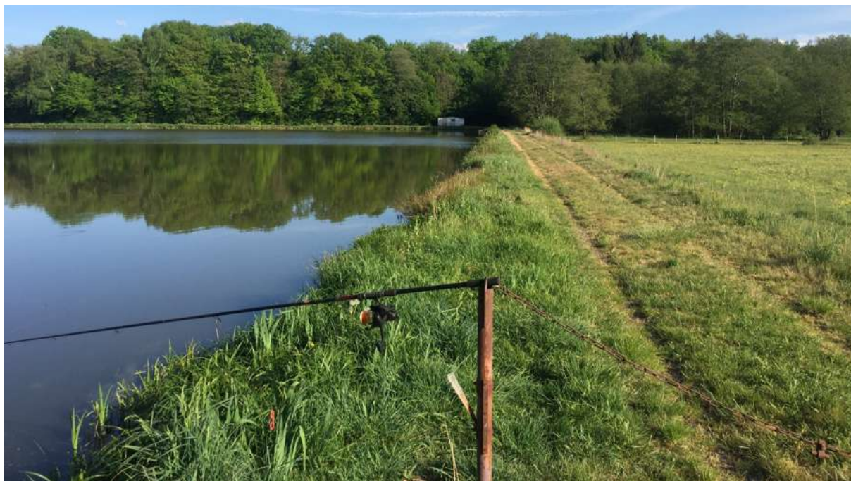
Vue de la digue
