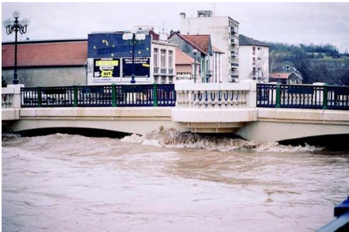
Figure 3-5 : Vue amont du pont Denfert-Rochereau dans Belfort, en février 1990 (source : étude EGIS, Aménagement des berges de la Savoureuse, 2015)
