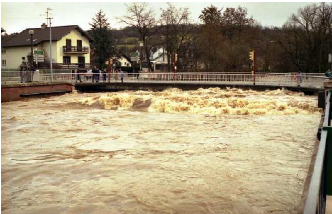
Figure 3-6 : vue amont du pont Richelieu dans Belfort, en février 1990 (source : étude EGIS, Aménagement des berges de la Savoureuse, 2015)
