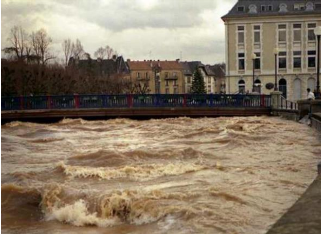
Figure 3-4 : Passerelle des Arts dans Belfort, en février 1990 (source : étude EGIS, Aménagement des berges de la Savoureuse, 2015)
