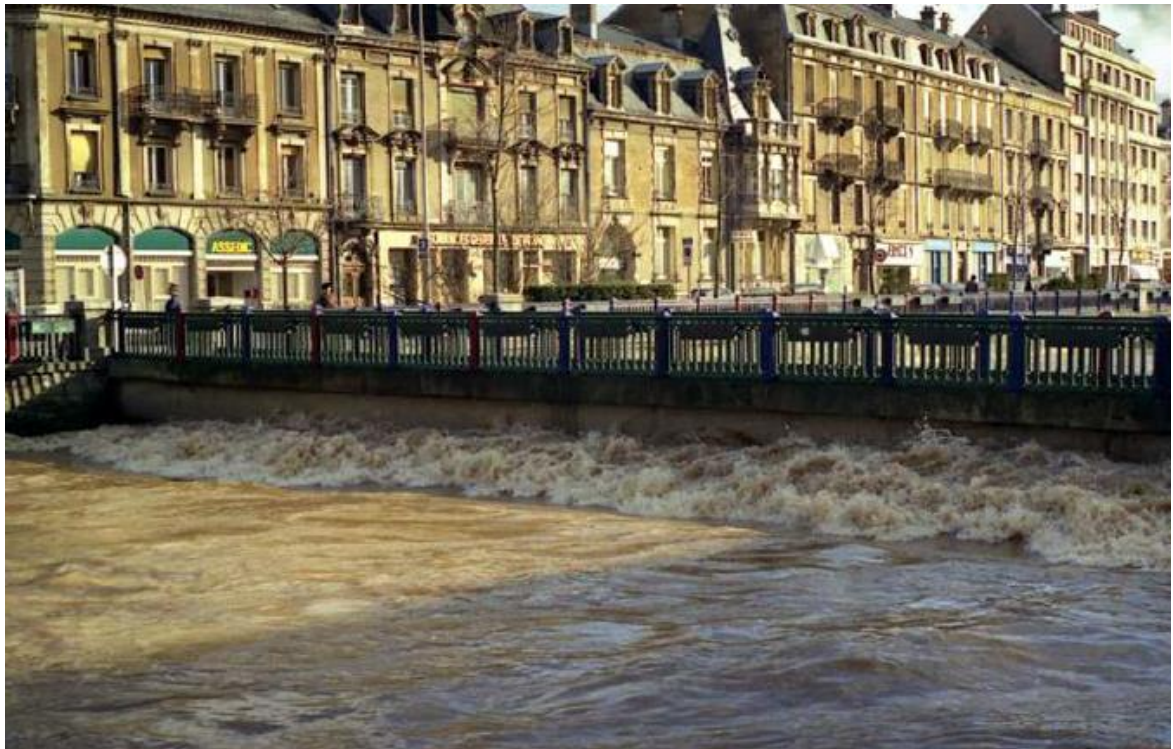
Figure 3-2 : Passerelle des Lettres dans Belfort en février 1990 (source : étude EGIS, Aménagement des berges de la Savoureuse, 2015)
