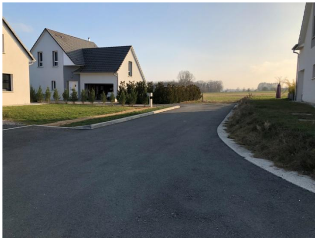
Nouveau lotissement avec démarrage de voirie en prévision d'extension futur
