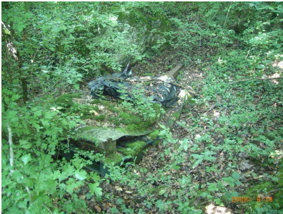
Figure 8 : Puits non comblés recouverts de palettes dans le bois d'Eguenigue INERIS DRS-08-96737-13901A
