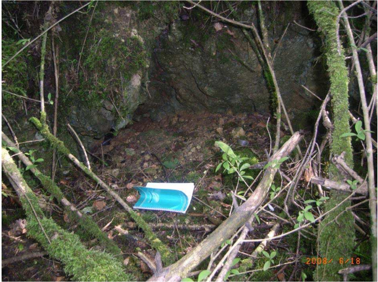
Figure 7 : Galerie remblayée dans le bois d'Eguenigue
