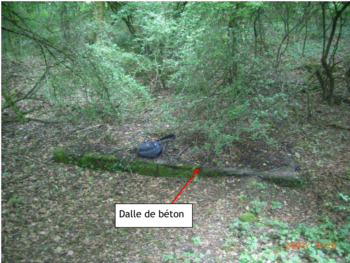
Figure 11 : Puits d'aération dallé, situé en pied du versant boisé bordant le ruisseau de l'Ermité
