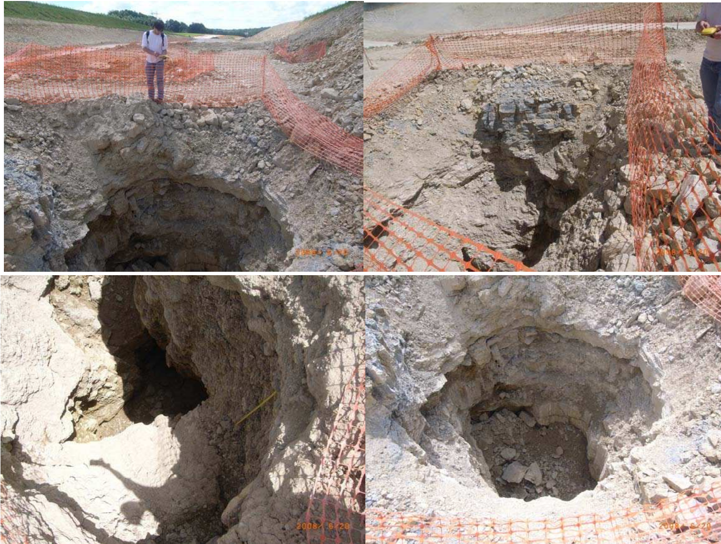
Figure 3 : Puits découverts lors du déboisement pour la construction de la LGV
