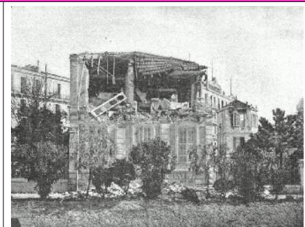
Destruction de bâtiments à Menton (06) suite au séisme de 1887 et à la liquéfaction des sols (Source : Les Tremblements de Terre - FA Fouqué)
