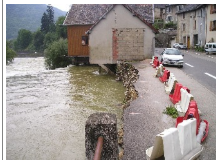
Érosion de berges à Lods (25) - 2006 (Source DLA)
