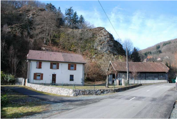
Constructions sous falaise à Auxelles-Haut (90) (photo BRGM).
