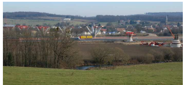
Configuration susceptible de créer un effet de site dans la plaine alluviale de la Savoireuse (90), avec le viaduc de la LGV Rhin-Rhône, dimensionné pour ce phénomène (photo BRGM).
