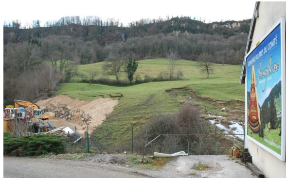
Exemple de glissement de terrain à Salins-les-Bains (39) (photo BRGM).
