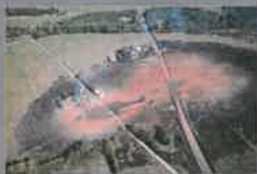
Conséquences d'une fuite sur une canalisation de transport, Appomattox (USA), 14 septembre 2008 (source : www.fox.com )
