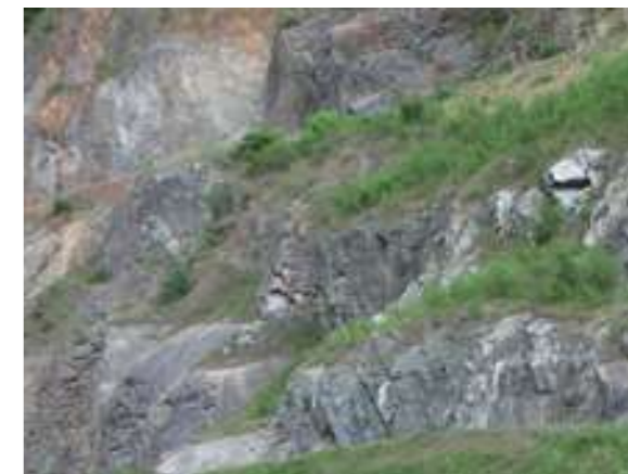
Fronts sud, en position définitive, talutés et recolonisés naturellement
