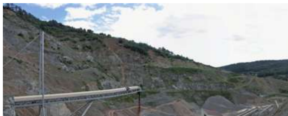
Fronts sud en cours de recolonisation végétale
