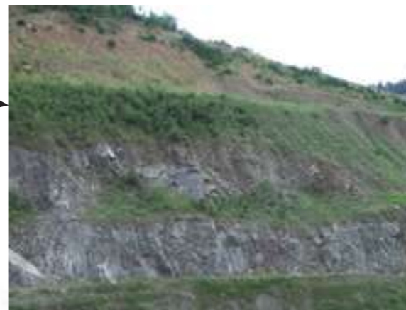
Fronts sud, en position définitive, talutés et recolonisés naturellement
