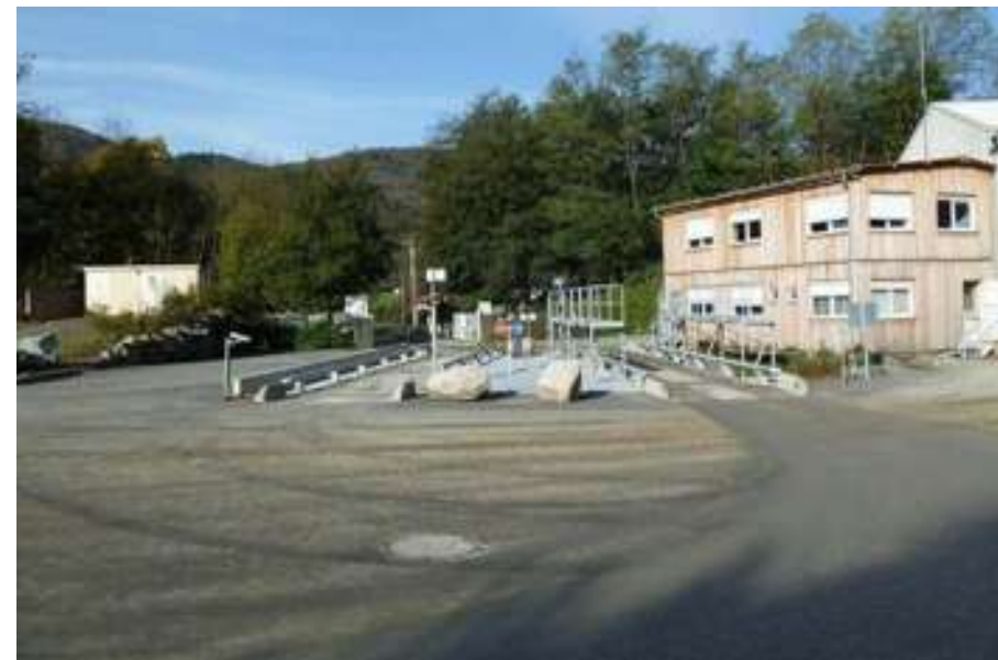
Entrée du site : enrobé et bascule double flux avec quai de bâchage (ENCEM)
