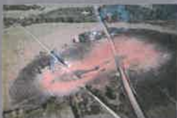
Conséquences d'une fuite sur une canalisation de transport, Appomattox (USA), 14 septembre 2008 (d'après www.energies.fr ).
