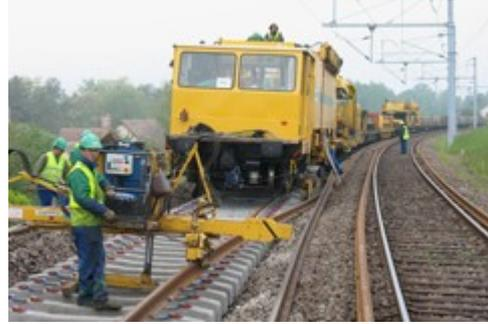
*Longs Rails soudés sur traverses béton*
