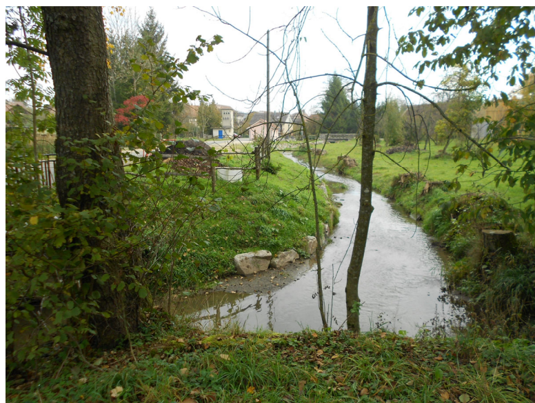
Figure 33 : Photo du pont de l'Écrevisse au niveau de Grosne, cliché SETEC HYDRATEC octobre 2011
