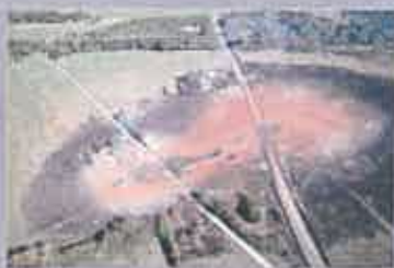
Conséquences d'une fuite sur une canalisation de transport, Appomattox (USA), 14 septembre 2008. (source : piazzi.org).
