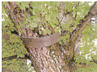
6 Haubanage des branches
