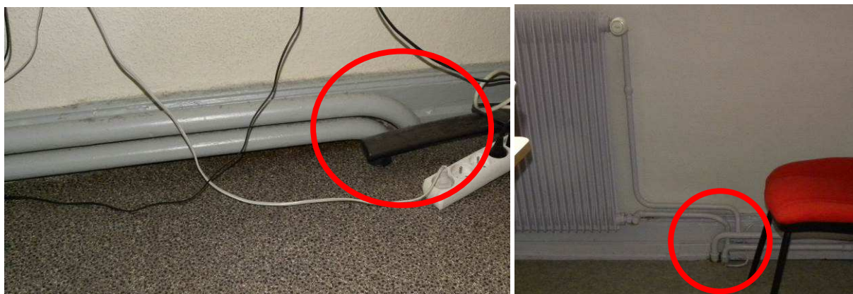
Exemple de colonne devant être coupée – Alimentation repris sur nouveau réseau
