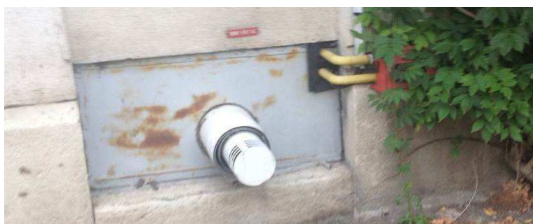
Remplacement de la plaque actuelle par une grille pour VB de la chaufferie.
